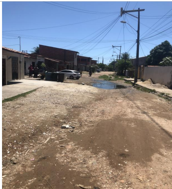
Figura 02 - Trecho da Rua do Matadouro.
