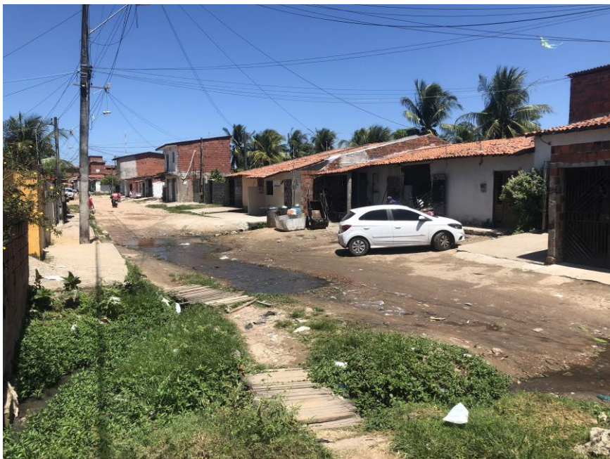
Figura 01 - Trecho da Rua do Matadouro.
